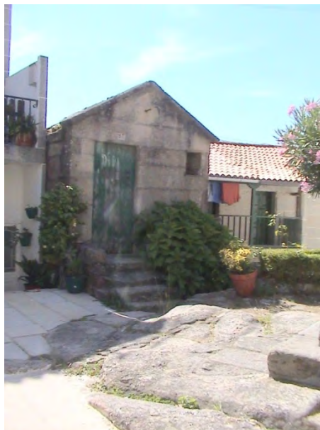
Ilustración 4 Casa de pincho (Foto: A. Mesía, agosto 2008)
