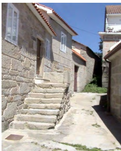
Ilustración 5 Casa con patín paralelo a la fachada y adosado a ella (Foto: A. Mesía, agosto 2008)
