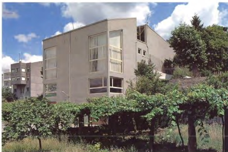
Concello de Pontecesures. Pontevedra. (César Portela Fernández- Jardón, en colaboración con Pascuala Campos)
