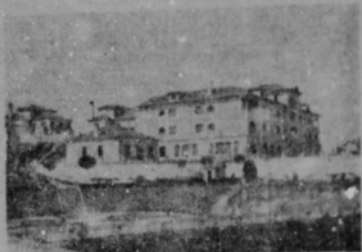
Hotel de Oficiales - Magnífica obra realizada conforme a las más modernas exigencias de los tiempos actuales.
